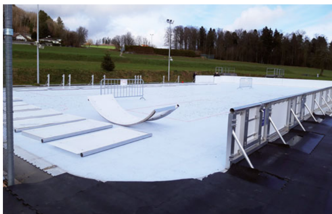
Bei der Demontage der Banden.
